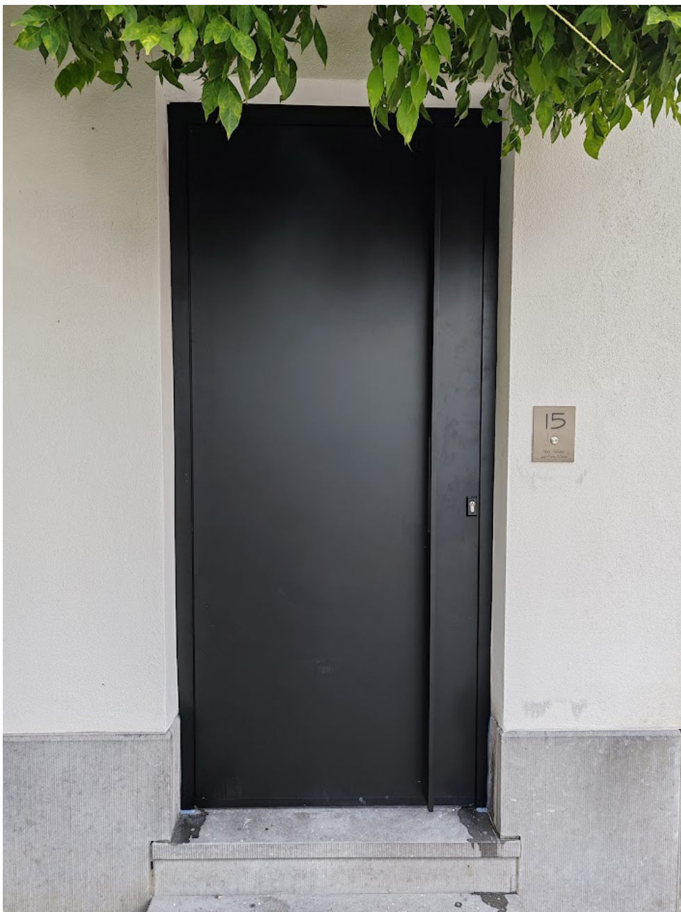
Aluminium vleugel overdekkende deur met vlak paneel in RAL 9005 structuur. Deur trekker Anaf collectie. Werf Boutersem.
