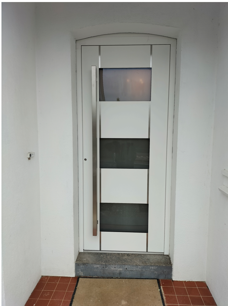
Aluminium vleugel overdekkende deur RAL wit structuur. DP 13 met inox afwerking. Werf Heverlee.
